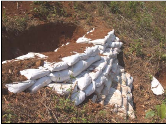
หมายเลข 15. ในแผนที่คืออาคารชะลอความเร็วน้ำ
