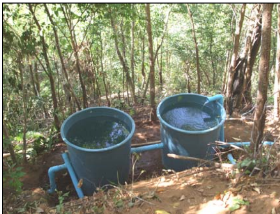
หมายเลข 11. ในแผนที่ แสดงด้วยจุดสามเหลี่ยมสีน้ำเงิน เป็นถึงน้ำไฟเบอร์ขนาด 1,000 ลิตร เพื่อลดแรงดันน้ำ
