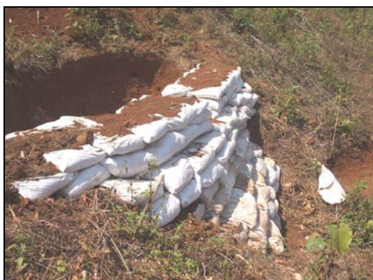
รูปที่ 2-4 อาคารชะลอความเร็วน้ำ ในพื้นที่
