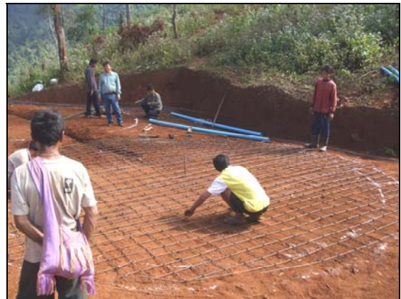
หมายเลข 12. ในแผนที่แสดงด้วยจุดกลมสีชมพู เป็นบ่อเก็บน้ำคอนกรีตเสริมเหล็ก (คสล.) เส้นผ่านศูนย์กลาง 6 เมตร
