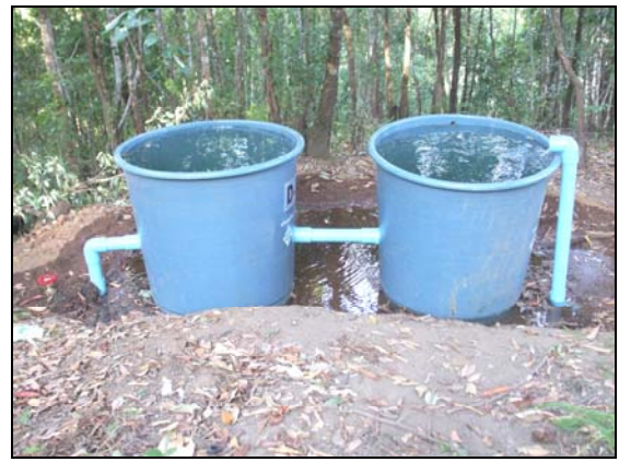
หมายเลข 11. ในแผนที่ แสดงด้วยจุดสามเหลี่ยมสีน้ำเงิน เป็นถึงน้ำไฟเบอร์ขนาด 1,000 ลิตร เพื่อลดแรงดันน้ำ
