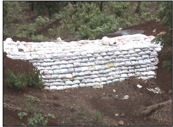
หมายเลข 15. ในแผนที่คืออาคารชะลอความเร็วน้ำ
