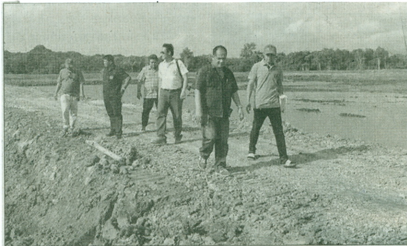
แหล่งน้ำชุมชน : นายก่อเกียรติ จันทร์พิงสุข ผู้อำนวยการสำนักงานพัฒนาที่ดินเขต 2 กรมพัฒนาที่ดินตรวจดูความคืบหน้าการก่อสร้างแหล่งน้ำชุมชนบ้านดอนเตี้ย และสายน้ำดินบ้านไทรทอง อ.ท่าใหม่ จ.จันทบุรี เมื่อเร็วๆ นี้
