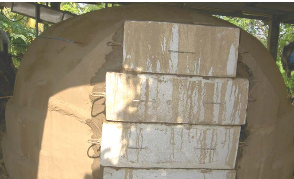
ปิดหน้าเตาด้วยแผ่นคอนกรีต
