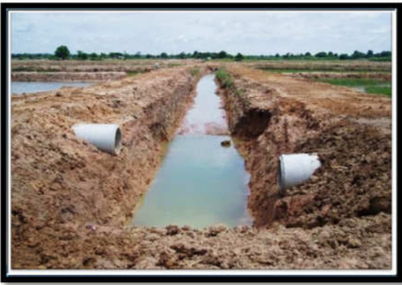
ภาพที่ ๕ การสร้างท่อลอดระบายเกลือ (Open drain)
