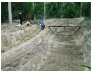
ขุดลอกตะกอนดินและทำร่องระบายน้ำ
