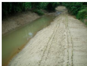
ขุดลอกตะกอนดินและทำร่องระบายน้ำ
